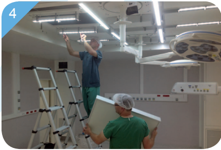
4 Pose des filtres H14 Étanchéité garantie Numéro de série sur chaque filtre
