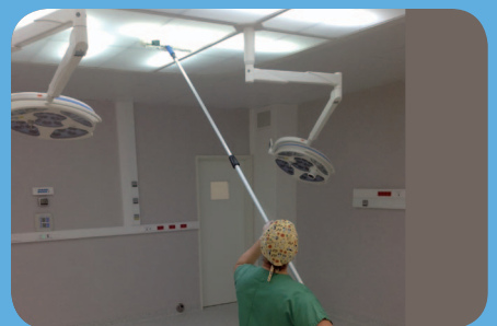
Surface lisse des toiles de diffusion pour faciliter le nettoyage et l'entretien
