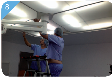
8 Pose des toiles de diffusion en nylon Rédaction d'un DOE comprenant toutes les mesures
