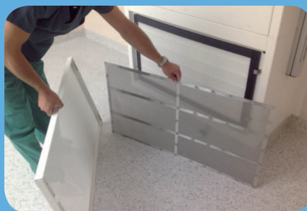
Grille en inox pour protéger les filtres des poussières et des peluches Durée de vie des filtres prolongée Remplacement simplifié des filtres
