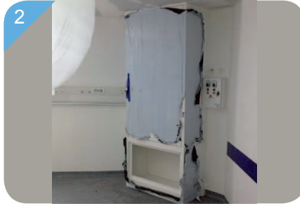
2 Pose des modules muraux Aluminium soudé livré en 2 parties Encombrement réduit
