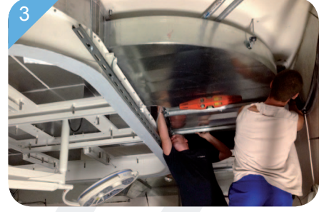
3 Pose des gaines de raccordement Étanchéité garantie Gaineurs confirmés et expérimentés
