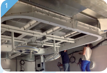
1 Fixation du plafond Aluminium soudé Livré en 2 parties
